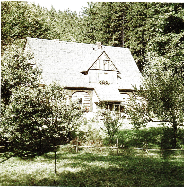
Das Forsthaus des »Zeughausförsters«
